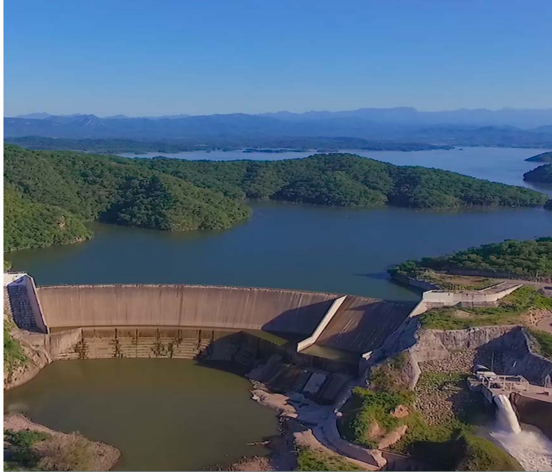
Presa Picachos, única fuente de abastecimiento de agua para Mazatlán Almacena el agua de la cuenca del río Presidio
